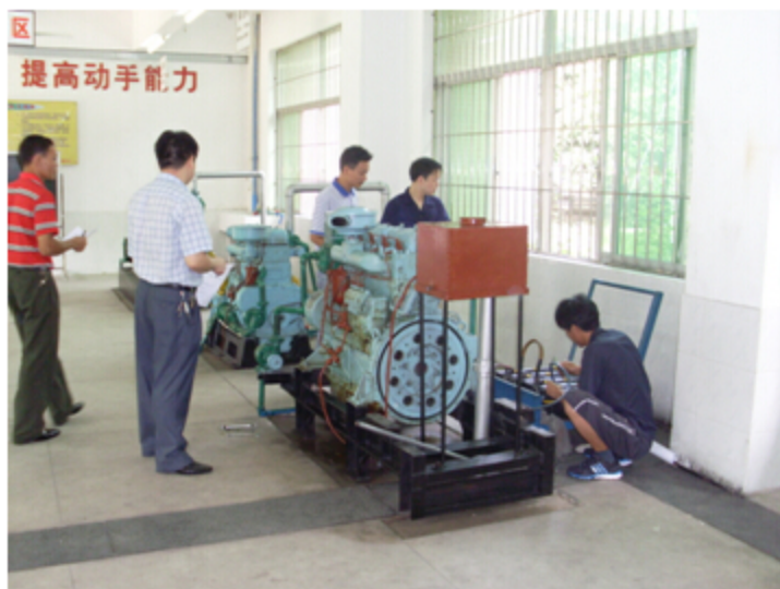
轮机拆装训练室
